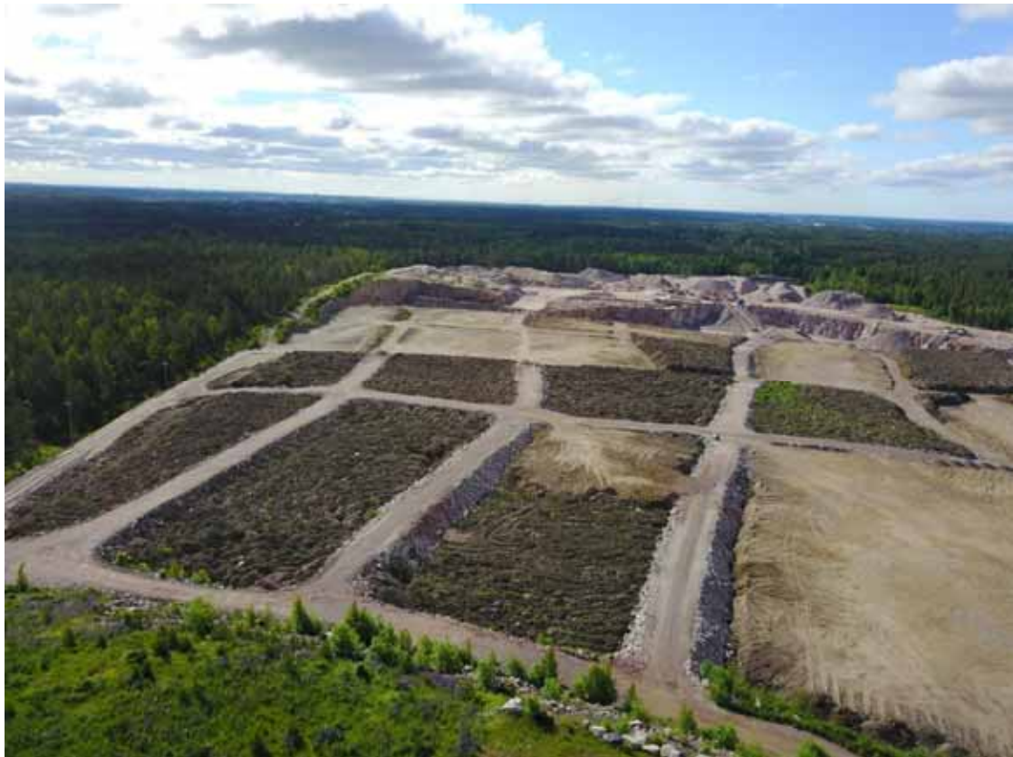
Kuva 5.61. Louherangalla toteutettavaa ylijäämämaan sijoitusta Espoon Kulmakorvessa. Kuva on vuodelta 2017.
